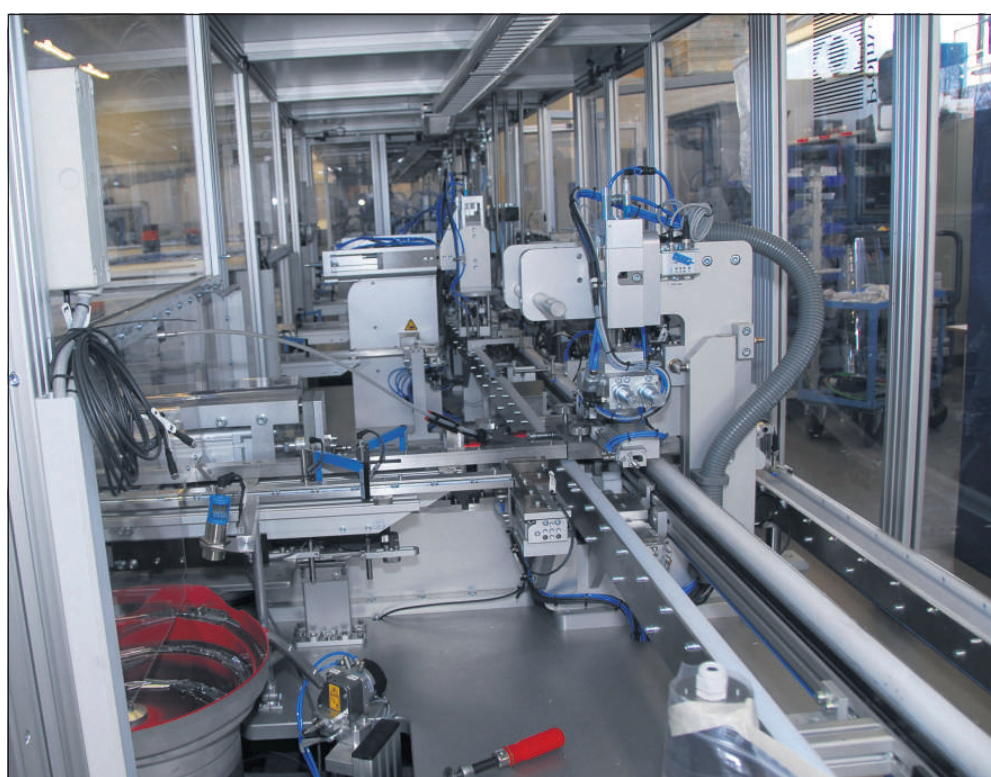
Linjen var efter FAT-test ved at blive demonteret, da J&M besøgte ProInvent, men man kan alligevel tydeligt fornemme, hvorledes der er tænkt på at gøre maskinen servicevenlig med god plads og fornuftig arbejdshøjde.
